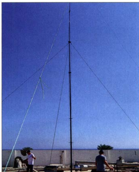
Unsere 10 m hohe Vierband-Vertikalantenne von Spiderbeam passte beim Transport gut in eine Golf-tasche; der Strahler für 80 m war L-förmig abge-spannt.
