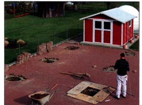
Bild 4: Als Modulträger dient ein Stahlgestell, das ein entsprechendes Fundament benötigt.
