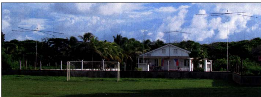
Antennenfarm rund um unsere kleine Villa (v. l. n. r.): Spiderbeam, 80-m-Vertikal, gepaste 30-m-Vertikalstrahler, 2-Element-Yagis für 12 m und 17 m, 4-Element-Yagi für 6 m, gepaste 40-m-Vertikalstrahler, zwei Spiderbeams, Vertikal für FT8
